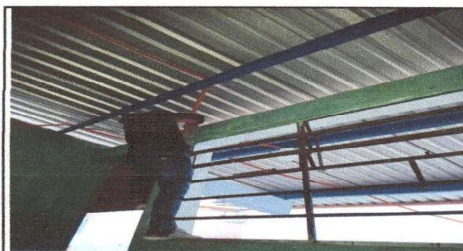
FOTO NO 6: CAMBIO DEL SISTEMA ELECTRICO.
