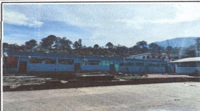
FOTO 1: SUSTITUCION DE TECHO
