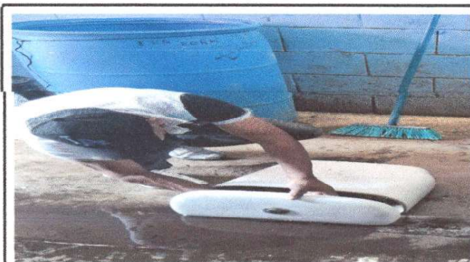
FOTO NO 4. CAMBIO DE ACCESORIOS DE SANITARIOS.
