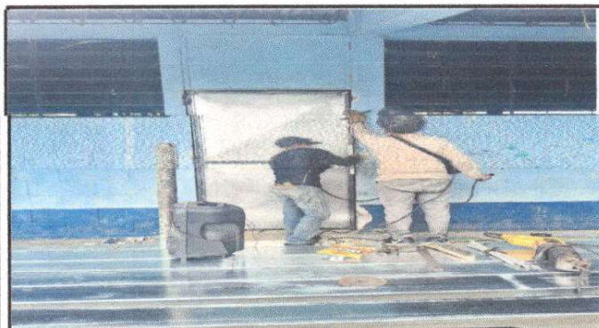
FOTO NO 3: SUSTITUCION DE PUERTA 1.
