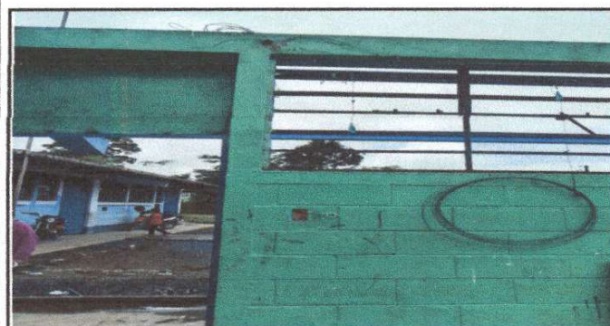
FOTO NO 5: CAMBIO DEL SISTEMA ELECTRICO.
