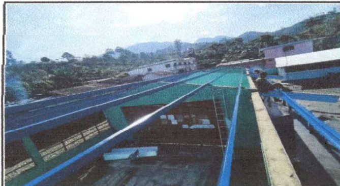
FOTO: SUSTITUCION DE TECHO.
